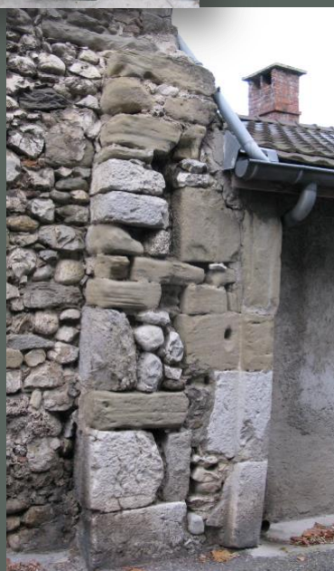
Vestiges de la porte de Racin ou de Saint-Laurent. Peut-être s'agit-il des traces de travaux commandés en 1321-1322.
