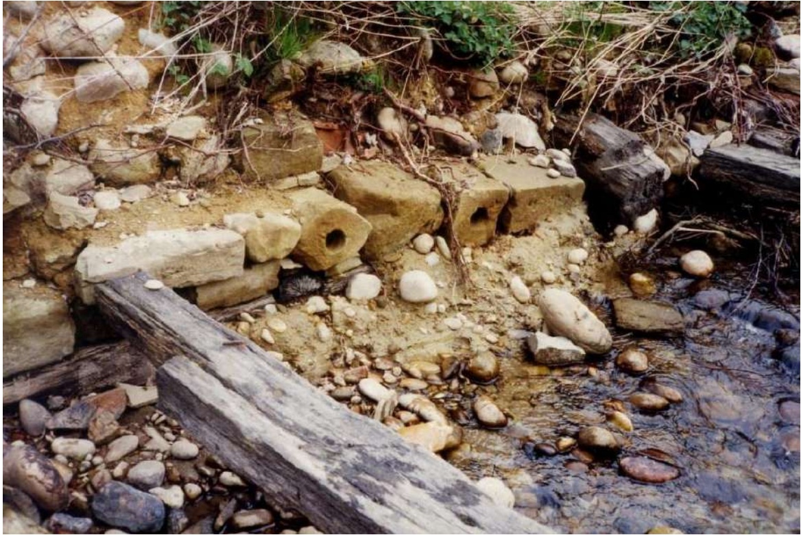
Figure 13 : La Gère, blocs en remploi dans la rive nord, ©J. Tardieu, mars 1994.
