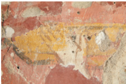
↓ Enduits peints médiévaux, dépose par des restaurateurs du patrimoine.
