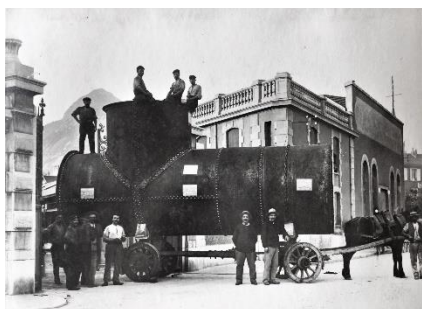
La sortie d'une conduite forcée de l'usine Joya à Grenoble, photographie sans date, Coll. Archives départementales de l'Isère Fonds 76J22
