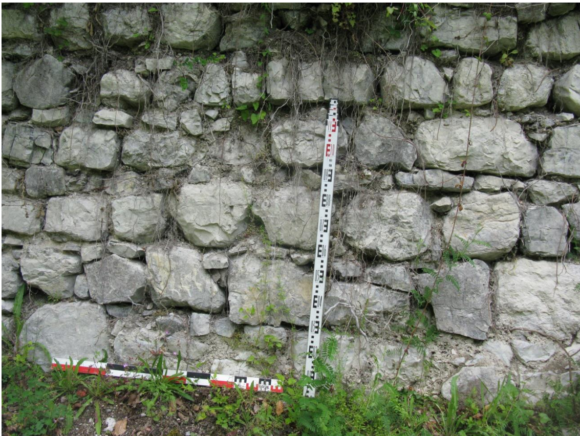
Figure 37 : le mur M23, détail de l'appareil. Cliché 2020
