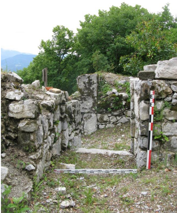
Figure 33 : La porte P10 dans M14, vue depuis le nord (intérieur). Etat en 2020.
