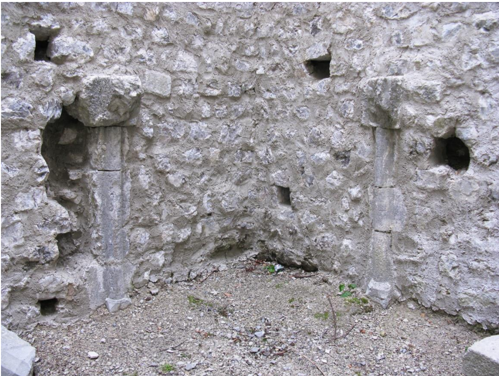
Figure 16 : la cheminée Ch01 (2014).
