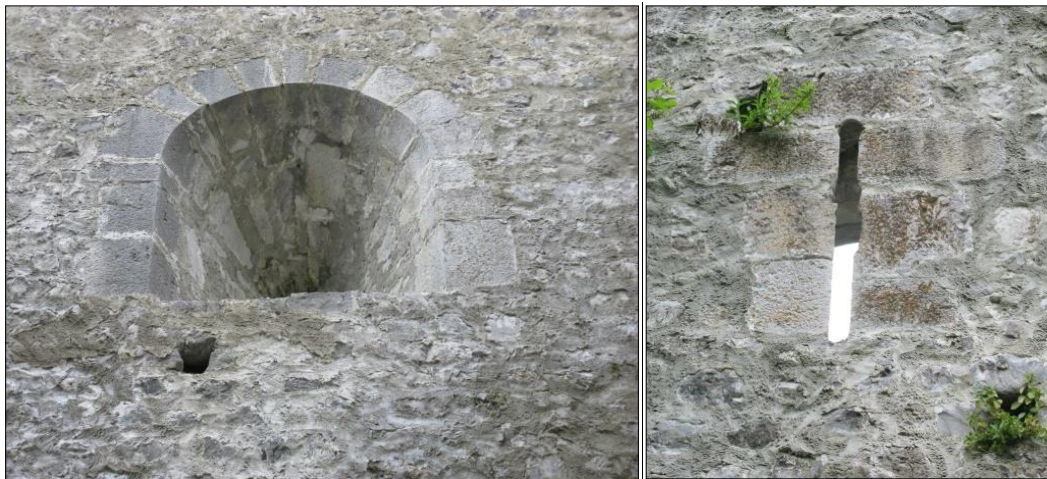
Figure 18 : Arbalétrière du premier étage.
