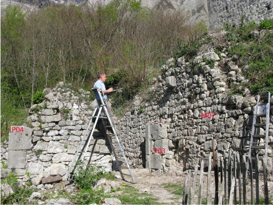
Figure 23 : vue porte P03 et tourelle M19
