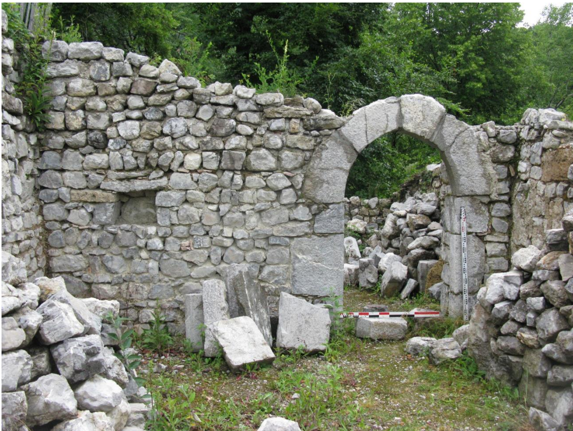
Figure 35 : Mur M17 et porte P12. Etat en 2020.
