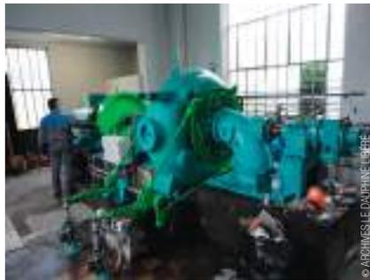
Centrale hydroélectrique rénovée en 2003 et 2017/2018, constituée de deux groupes de production de 220 et 320 kW. Ancien site des usines MIVA de sérigraphie sur soie. Elle a alimenté les usines en électricité pendant une longue partie du siècle dernier.
