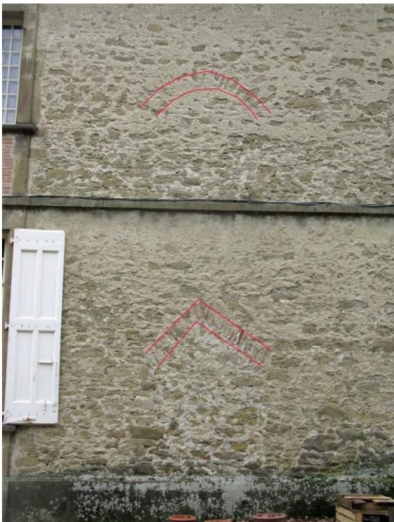
*Figure 19 : arcs de décharge signalant la présence de conduits de cheminée. Mur nord, R+1 et R+2.*
