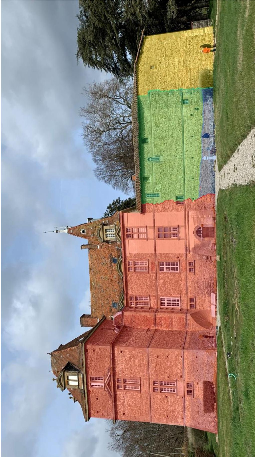
**Figure 14** : Les trois grandes phases de construction du château. DAO A. Clavier.
